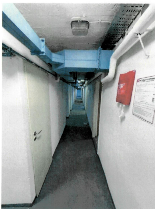
Fot. 46_47– wyjście kanału na korytarz i przebieg kanału wzdłuż korytarza
