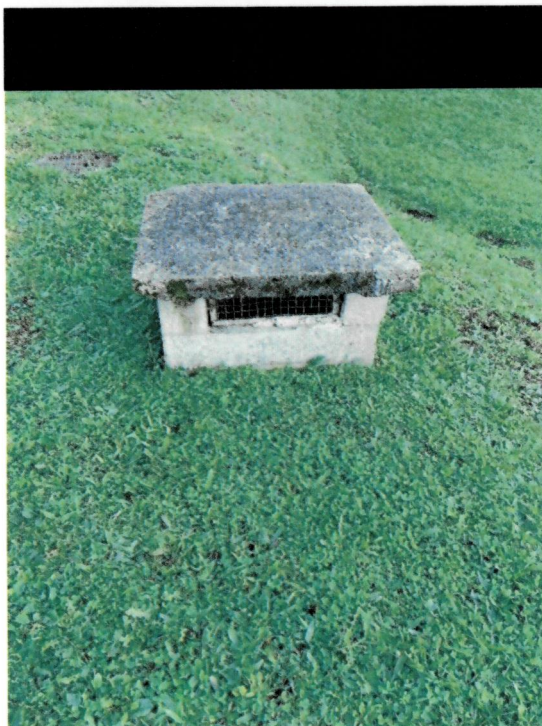
Fot. 40_41 – wylot spalin z zespołu spalinowo – elektrycznego
