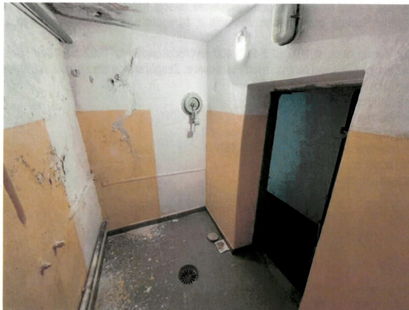
Fot. 62 – WZS z podejściami do baterii natryskowej odpływem podłogowym i klapą WKS-100
