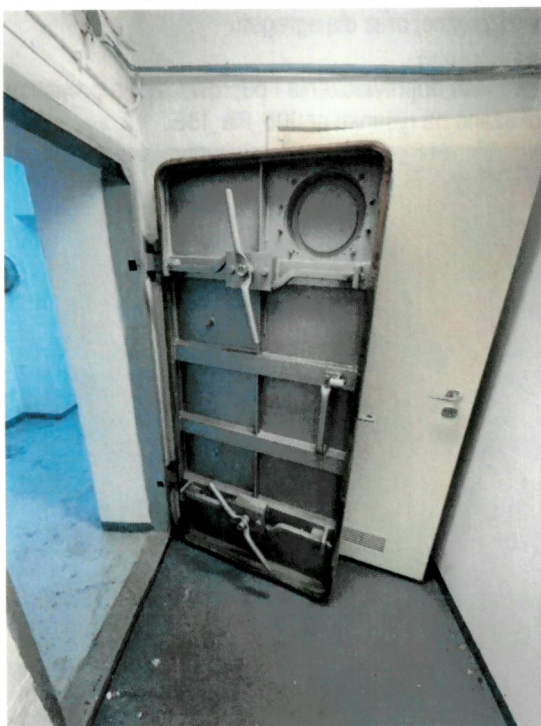
Fot. 54_55 – WKS w strefie przedsionka wejścia od zewnątrz zamontowany w konstrukcji drzwi ochronno-hermetycznych
