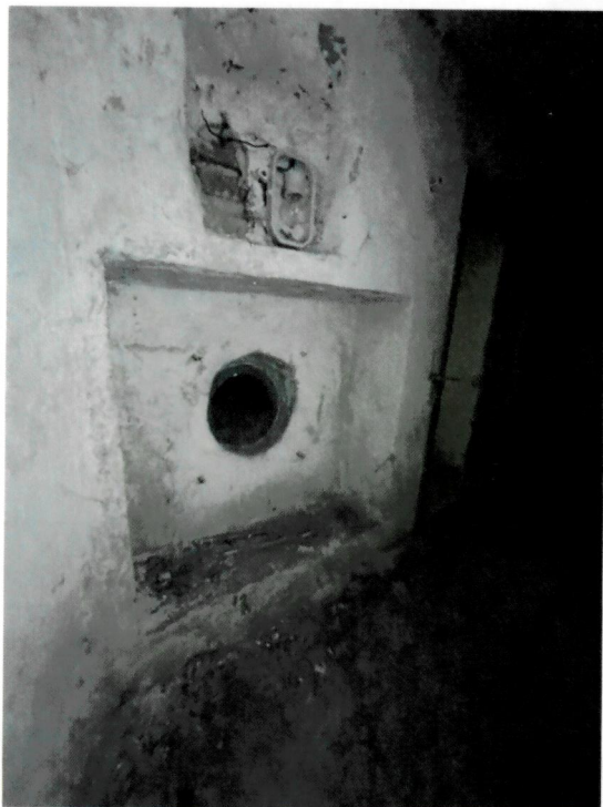
Fot. 48_49 – wloty powietrza do komory rozprężnej oraz dla agregatu
