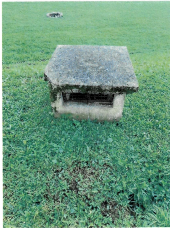
Fot. 40_41 – wylot spalin z zespołu spalinowo – elektrycznego
