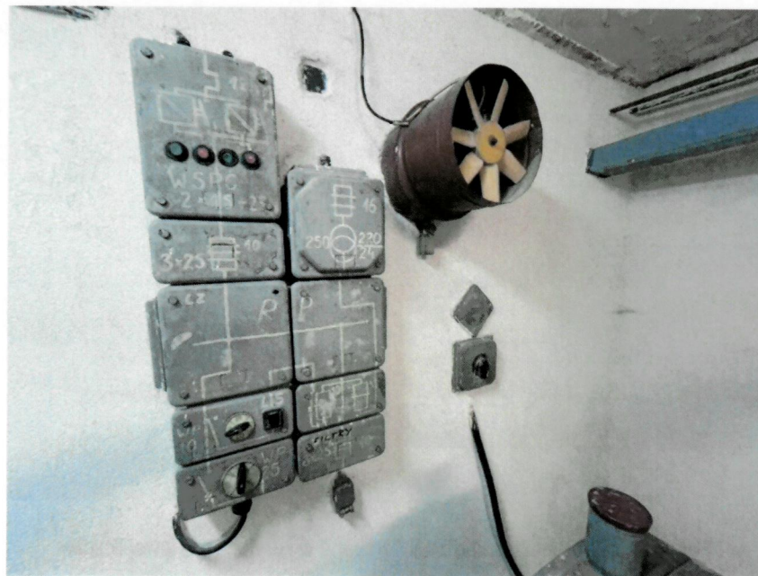
Fot. 65 – tablica sterująca zespołu spalinowo-elektrycznego
