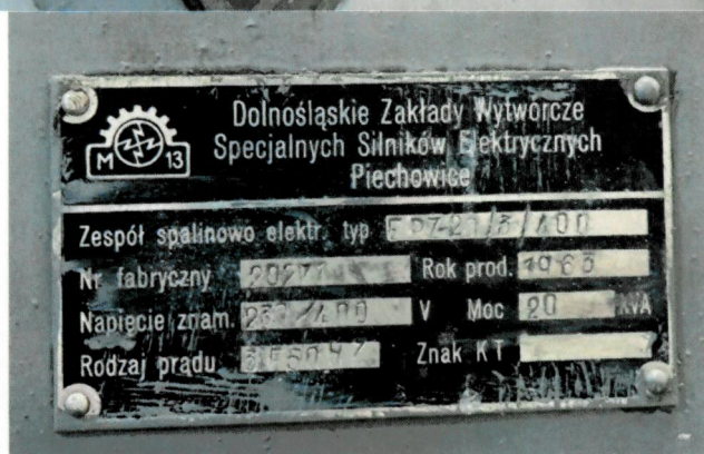
Fot. 64 – agregat spalinowo-elektryczny, tabliczka znamionowa
