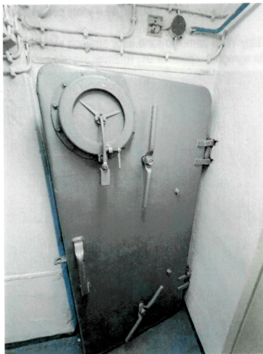
Fot. 54_55 – WKS w strefie przedsionka wejścia od zewnątrz zamontowany w konstrukcji drzwi ochronno-hermetycznych
