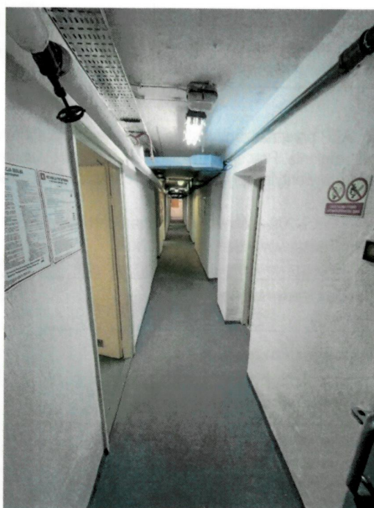
Fot. 46_47– wyjście kanału na korytarz i przebieg kanału wzdłuż korytarza
